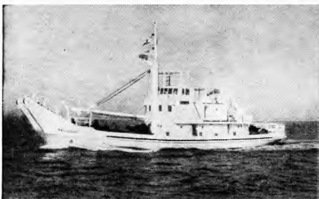
Sl. 4. Brod za dizanje plutača preko pramca
