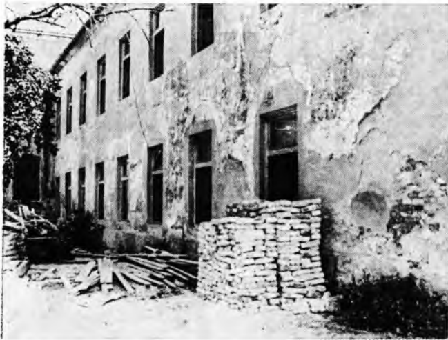
Sl. 17. Izgled fasade škole u Prelogu prije i poslije elektroosmotskog sušenja
