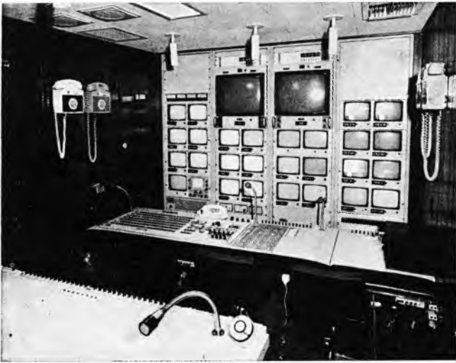
Sl. 84. Kontrolni pult i stijena s kontrolnim monitorima glavne programske režije
