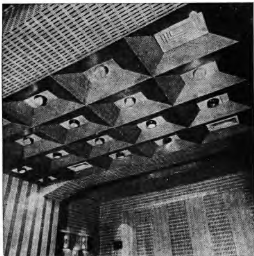
Sl. 91. Pogled na zid i strop studija. Vide se perforirane drvene šper-ploče
