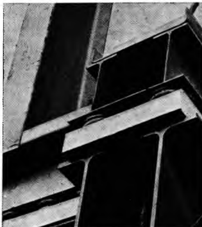
Sl. 88. Specijalne opruge na vanjskim betonskim zidovima podruma ispod nosača unutarnjih zidova studija
