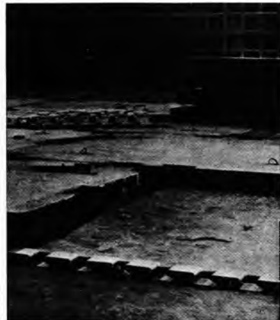
Sl. 89. Polaganje betonskih ploča plivajućeg poda »kutije u kutiji« na uzdužne čelične opruge
