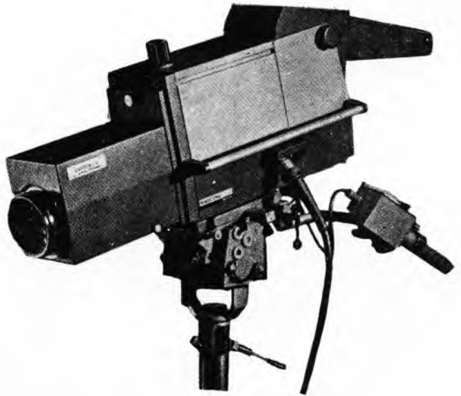
Sl. 79. Televizijska kamera sa superortikonom i zum-objektivom
