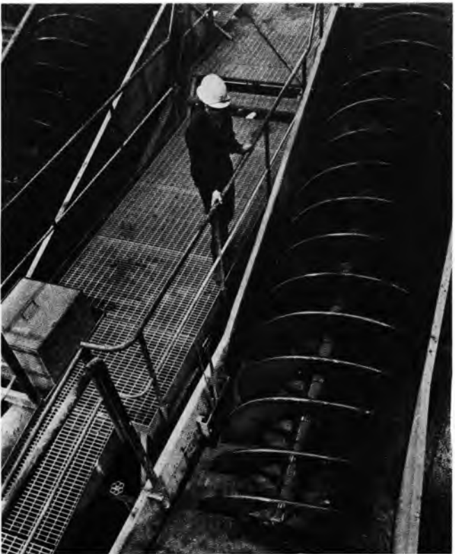
Sl. 33. Klasifikator sa spiralom
