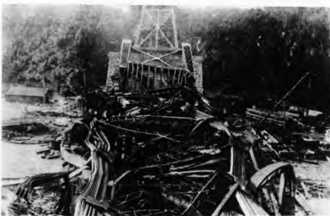
Sl. 1. Srušeni bočni otvor mosta preko reke St. Lawrence, Kanada (1907)
