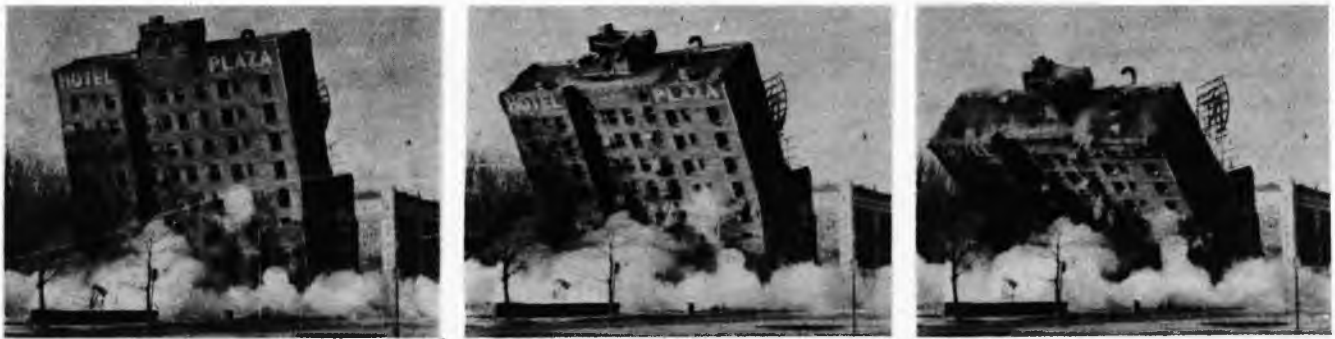
Sl. 14. Rušenje zgrada miniranjem: rušenje u stranu (gore) i urušavanje (dolje)
