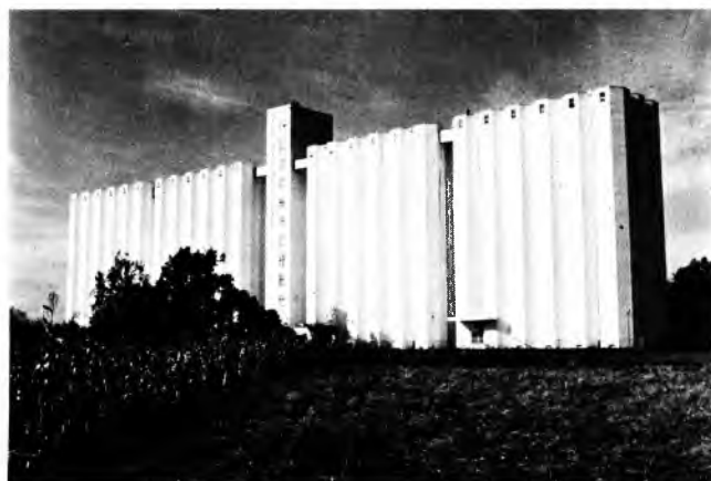
Sl. 4. Silos za žito u Zagrebu, kapacitet 56000 t
