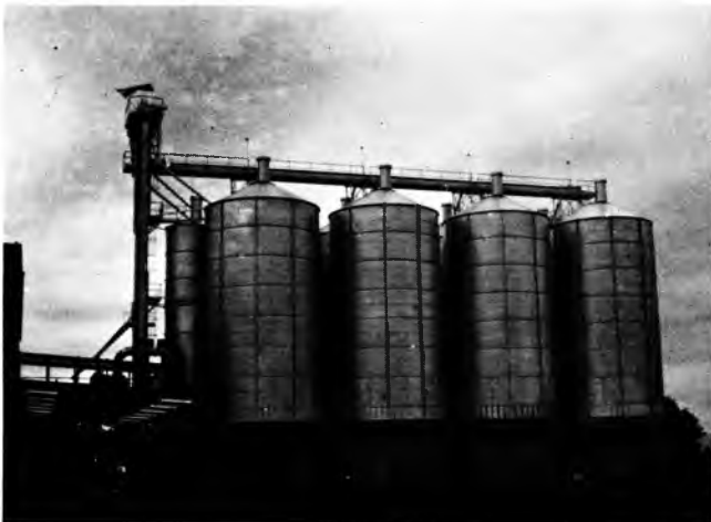
Sl. 7. Silos za žito u Kutjevju, kapacitet 8000 t
