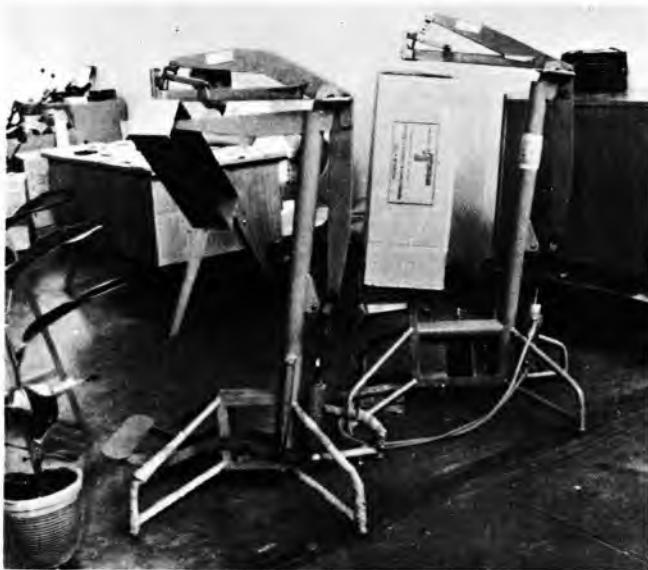
Sl. 41. Mašine za spajanje čeličnim spojnicama
