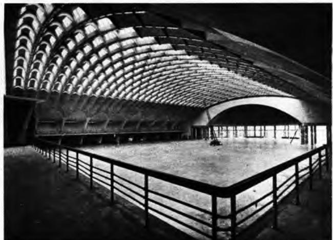
Armiranobetonska konstrukcija: izložbena dvorana u Torinu (arh. P. L. Nervi, 1948—50)
