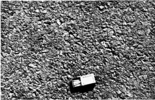
Sl. 5. Hrapava površina asfaltnog betona na autocesti Zagreb—Ljubljana
