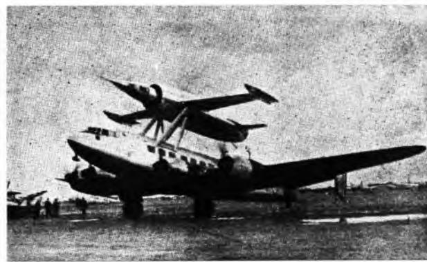
Sl. 13. Spreg: noseći avion i Atodid »Leduc«
