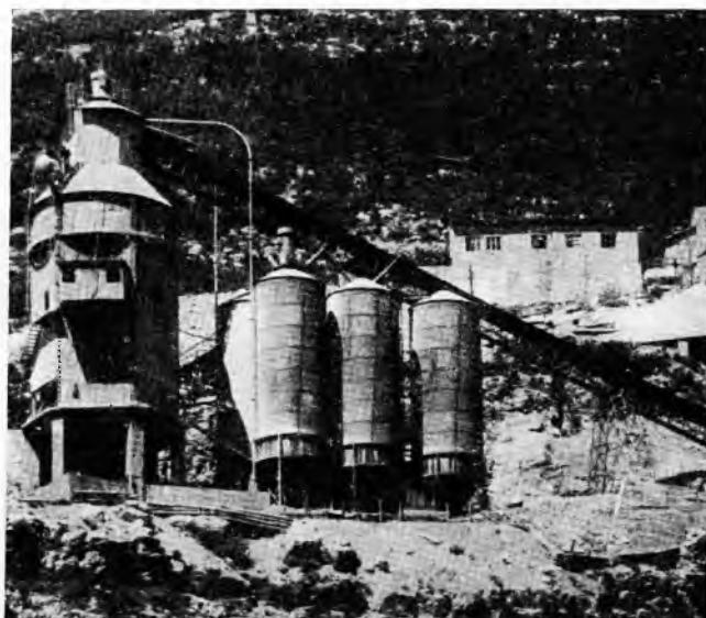
Sl. 12. Toranj za masovno spravljanje betona na gradilištu brane «Grančarevo»
