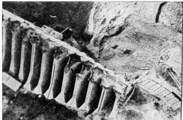
Sl. 24. Olakšana gravitaciona brana Ben-Metir u Tunisu, visine 60 m. Razmak kontrafora iznosi 14 m a spojeni su deformabilnim spojnicama (sl. 27). Uzvodni nagib 1 : 0,45. Dovršena 1955
