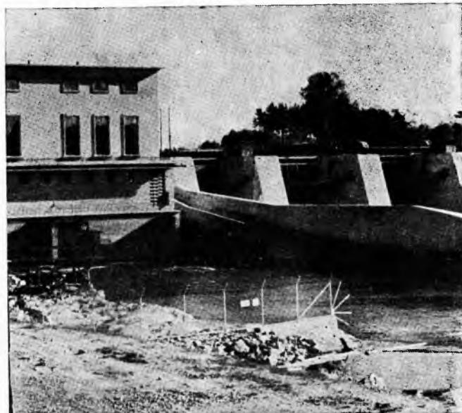
Sl. 6. Brana hidroelektrane Gráda u Švedskoj. Protočna polja imaju segmentne ustave podiznog tipa, koje se danas vrlo često primjenjuju jer su najlakše. Korito između zgrade centrale i protočnih polja služi za propuštanje debala
