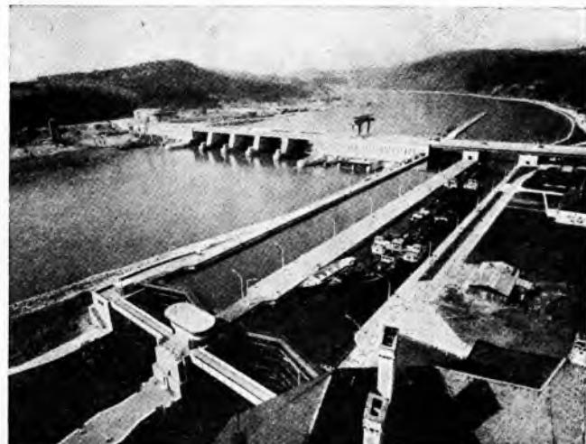
Sl. 5. Hidroelektrana Ybbs-Persenbeug na Dunavu u Austriji. Uspor vode visine 11 m čini pet protočnih polja s ustavama; centrala su smještene s obje strane; na lijevoj obali nalaze se dvije brodske splavnice koje omogućavaju istovremenu plovidbu u oba smjera
