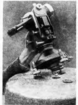
Sl. 32. Centriranje instrumenta pomoću dodatnog kuglastog nastavka
