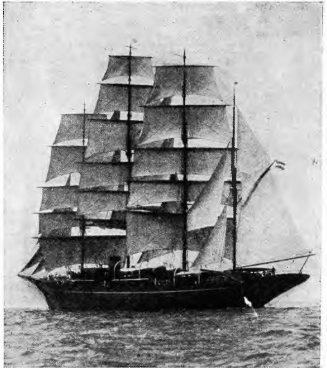
Sl. 6. Jahta-bark »Hussar«; \Delta = 3100 t, 3300 m 3 jedrilja (dvostruko više nego odgovarajući nekadašnji teretni jedrenjaci)
