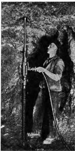
Sl. 4. Teleskopski bušači čekić
