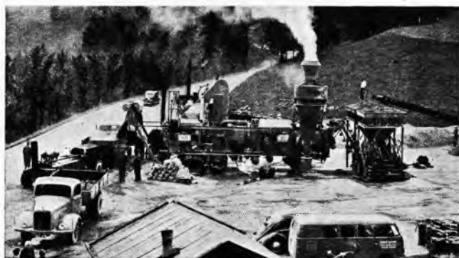
Sl. 69. Asfaltna mašina u procesu proizvodnje asfaltna mase
