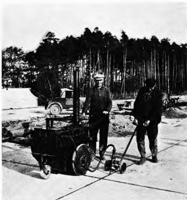
Sl. 84. Zalivanje spojnice mašinskim putem
