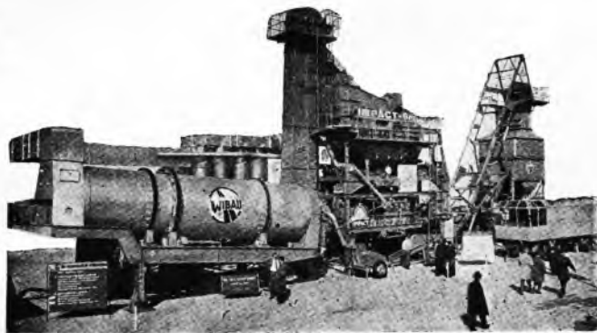
Sl. 97. Mašina za izradu asfaltne mešavine kapaciteta 200 t/h
