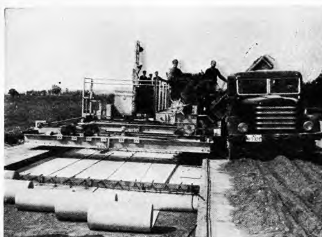
Sl. 81. Razastiranje betona razastiračem pored spojnice
