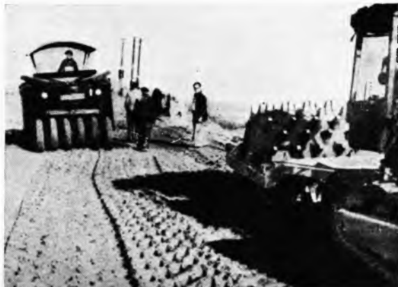
Sl. 55. Stabilizacija tla cementom sa nabijanjem ježom i gumenim valjkom
