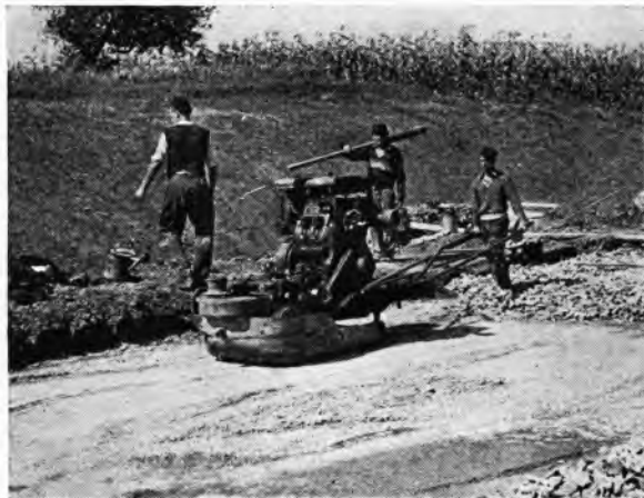
Sl. 93. Pločasti vibrator za nabijanje i stabilizaciju tla, peskovito-sljunkovitog materijala i tucanika
