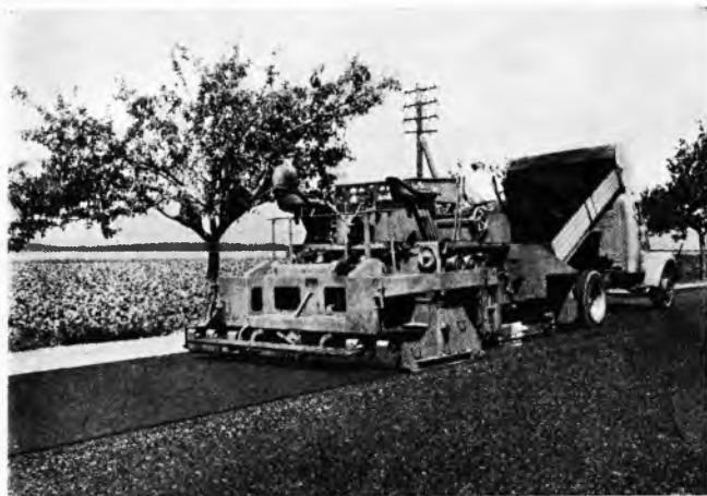
Sl. 70. Ugrađivanje asfaltnog betona finišeom »Barber Greenes«
