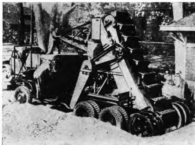
Sl. 96. Mašina-elevator za utovar kamenog agregata
