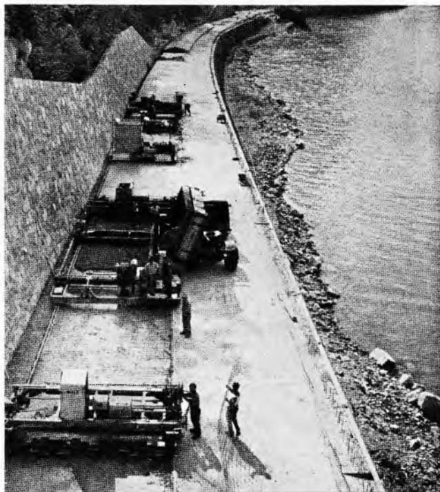
Sl. 91. Mehanizovano građenje ceste
