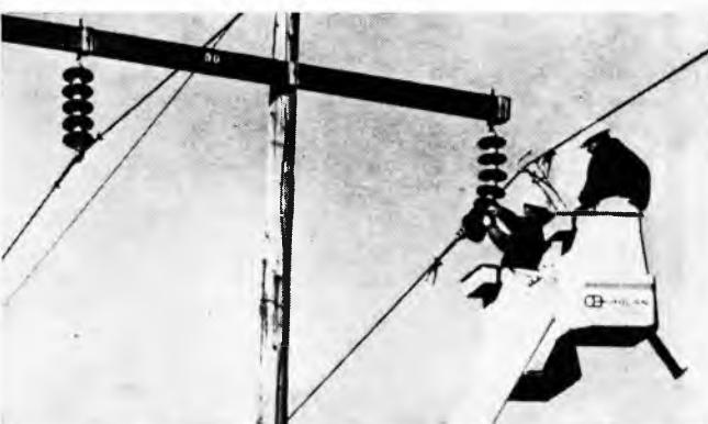
Sl. 67. Rad pod naponom u izoliranoj košari
