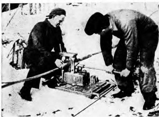
Sl. 21. Kompresiona spojnica (montaža)
