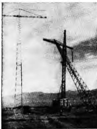
Sl. 58. Podizanje čeličnog trupa usadišvanjem
