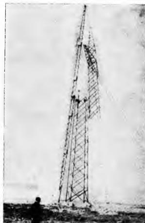
Sl. 59. Podizanje čeličnog stupa u dijelovima
