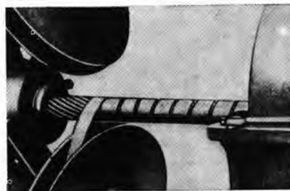
Sl. 81. Obavljanje armature od čelične žice čeličnom trakom
