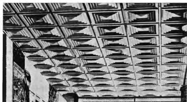
Svetlosni strop složen od reljefnih kapa od plastičnog materijala i fluorescentnim sijalicama iznad njih. Moguć je smještaj električnih, ventilacijskih ili klimatizacijskih instalacija
