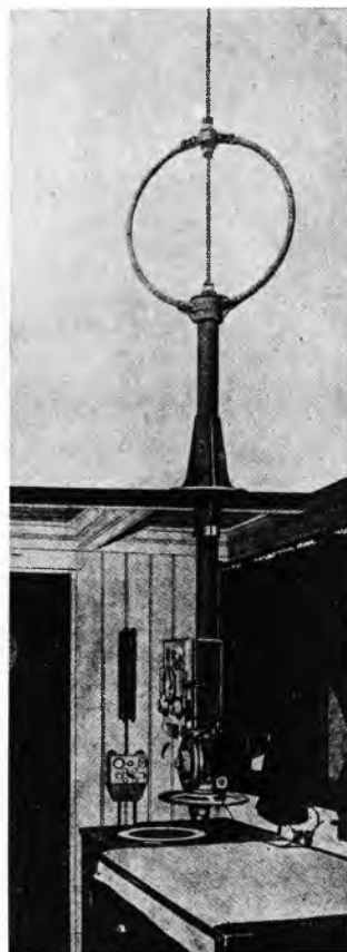
Sl. 8. Goniometar s okretljivim okvirom; vidi se i pomoćna štap-antena za određivanje strane
