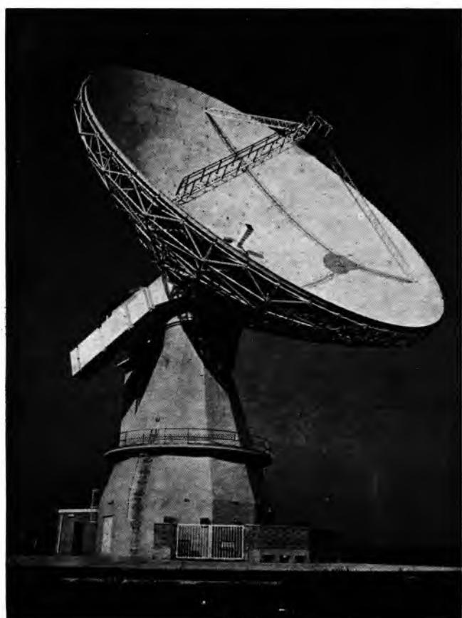
Sl. 44. Antena s parabolnim reflektorom za satelitske veze
