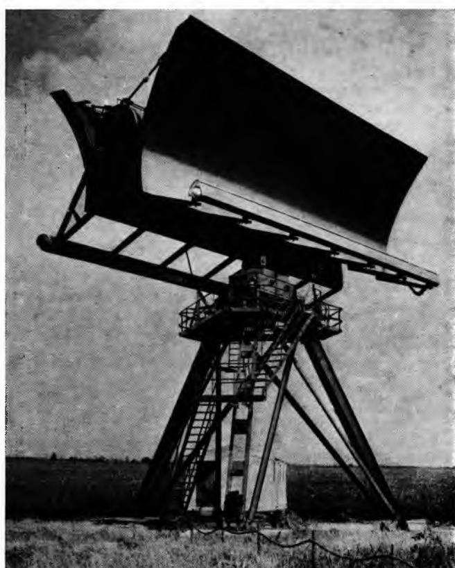
Sl. 46. Kombinacija dviju radarskih antena za 10-centimetarsko i 23-centimetarsko područje. Kao primarni radijator služe valovodi s prorezima, a kao reflektori isječci parabolnog cilindra
