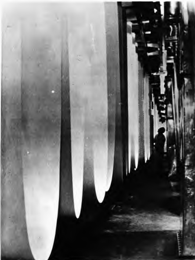
Sl. 81. Baritirani papir u vjesovima prolazi dvoranom za sušenje
