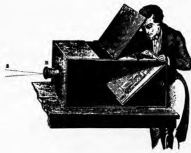
Sl. 3. Prijenosna camera obscura s početka XIX st.
