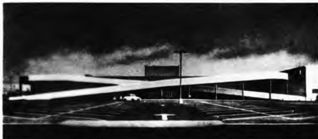
Sl. 8. Garaža sa pravolinijskim jednosmernim rampama koje se ukrštavaju na istoj strani (Los Angeles)
