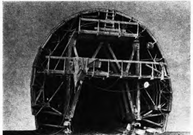
Sl. 4. Oplata za betoniranje tunelske obloge s donjom podgradom
