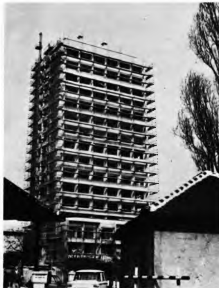
Sl. 16. Drvena skela (gore) za popravak tornja katedrale u Zagrebu (1939) i skela od čeličnih cijevi (dolje) za izradbu fasade (1978)
