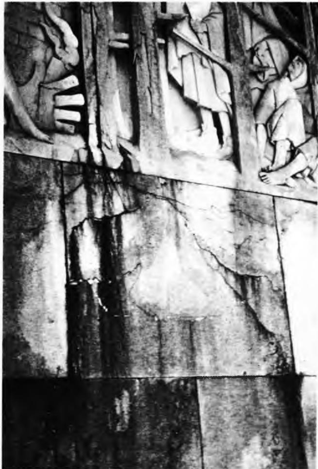
Sl. 15. Teško oštećenje kamene obloge na betonskoj konstrukciji spomenika zbog niza uzroka, prvenstveno slabe izolacije
