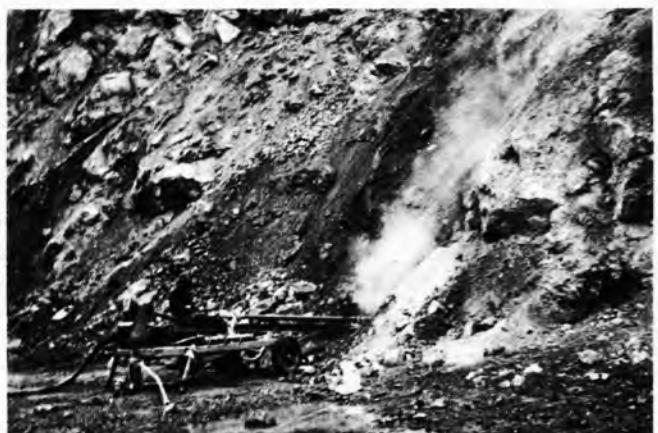
Sl. 23. Bušenje rupe za stavljanje eksploziva u nožici vertikalne fronte radilišta
