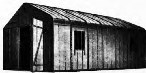
Sl. 17. Montažna limena zgrada tipa »Arbec«
