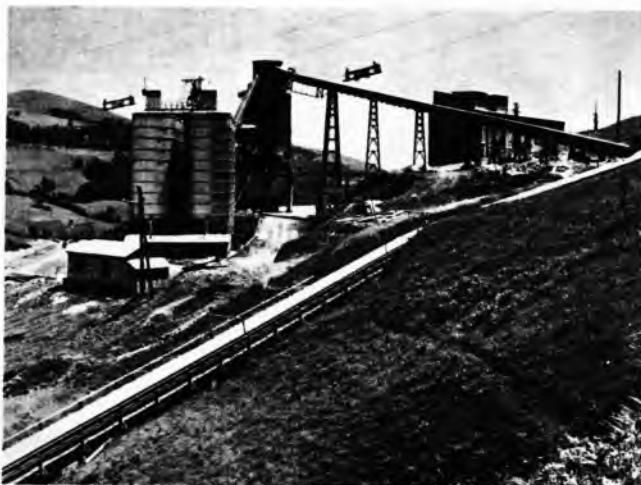
Sl. 6. Gradilište HE »Bajina Bašta«; centralna tvornica betona kapaciteta  $120 \text{ m}^3 \text{ h}^{-1}$
