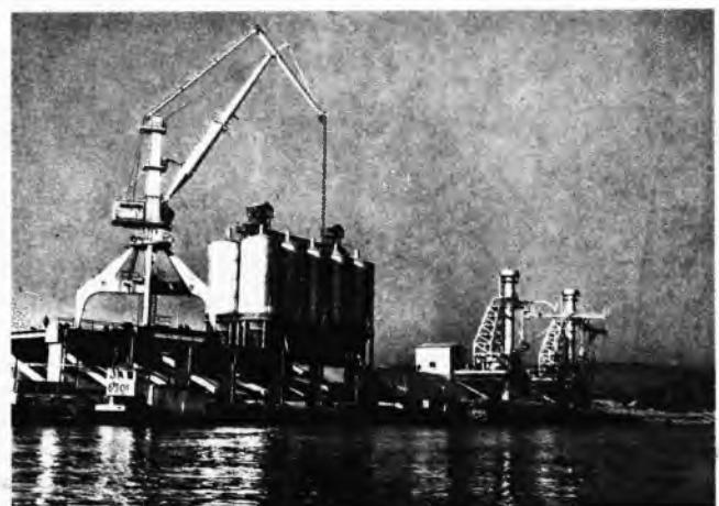
Sl. 8. Pristanište na gradilištu HE Derdap; uređaji za istovar cementa i silosi
