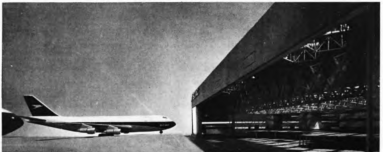
Sl. 21. Čelični hangar za Jumbo-jetove na aerodromu Heathrow
