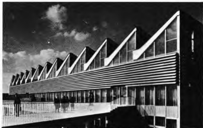
Sl. 9. Šed-krov aerodromske zgrade u Varšavi
