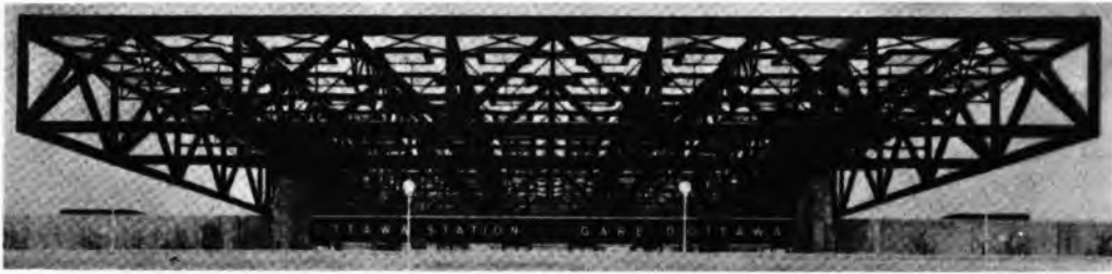
Sl. 18. Hala kolodvora u Ottawi
