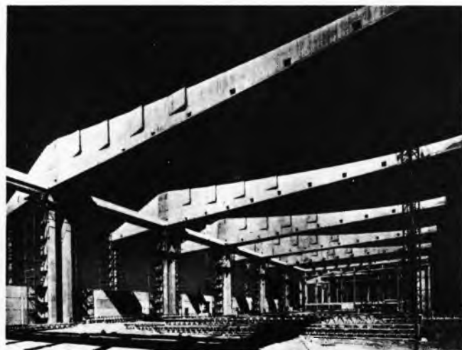
Sl. 11. Hangar na aerodromu Landsberg (SR Njemačka) za vrijeme gradnje
