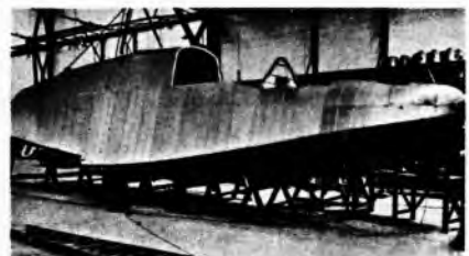
Sl. 37. Ljuskasta konstrukcija metalnog hidrotropa
