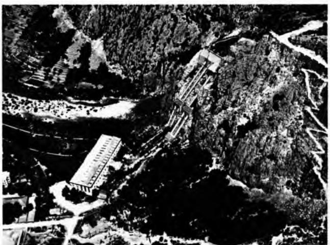
Sl. 23. Pogled na kraj dovodnog kanala, vanjske tlačne cijevi, strojarnicu i odvodni kanal HE Kraljevac na Cetini
