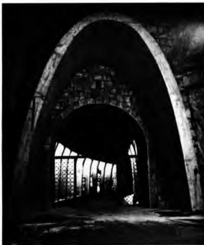
Sl. 36. Portali na ulazu u podzemne strojarnice. Lijevo portal u HE Jajce I sa zaštitnom maskom i pristupni tunel sa zaštitnim svodom protiv prokopljivanja, rebrima, nosačima i indirektnom rasvjetom; desno portal u HE Rama s izvodima 220 kV. Reljef na portalu je rad kipara Kockovića i predstavlja razvoj narodnooslobodičke borbe i bitku na Neretvi. Portal je zaštićen od eventualnog rušenja blokova
