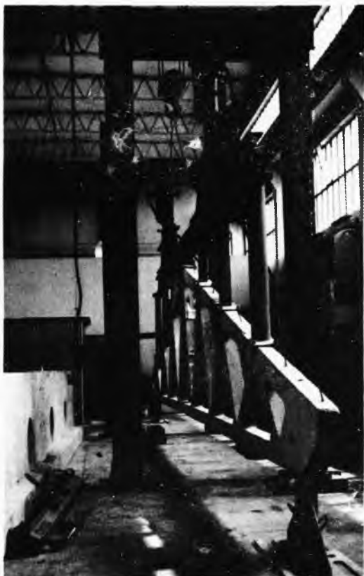
Sl. 45. Primjer opterećenja konstrukcije u laboratoriju
