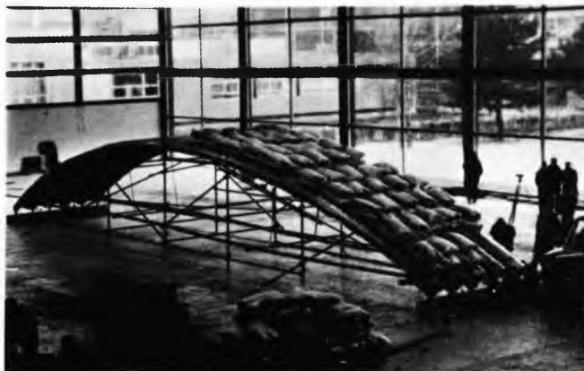
Sl. 44. Primjer opterećenja pri statičkom ispitivanju konstrukcija
