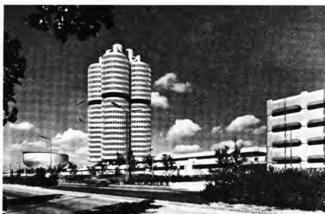
Sl. 48. Upravna zgrada tvornice BMW u Münchenu, K. Schwantzer
