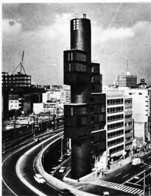
Sl. 51. Upravna zgrada novinskog i radio-poduzeća Shizuoka u Tokiju; K. Tange, 1967.
