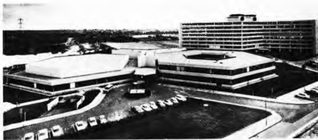
Sl. 22. Financijski i računovodstveni uredi centralne uprave tvornice boja Hoechst A. G. u Frankfurtu na Majni; H. Hentrich i H. Petschnigg
