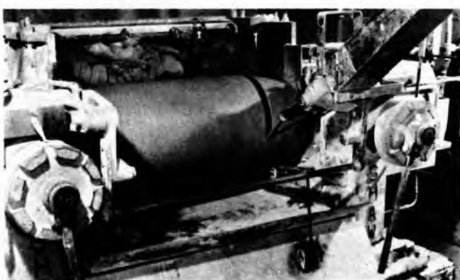
Sl. 6. Uređaj za mastikaciju pomoću valjaka. S prednjeg se valjka kontinuirano reže i odvodi traku kaučuka
