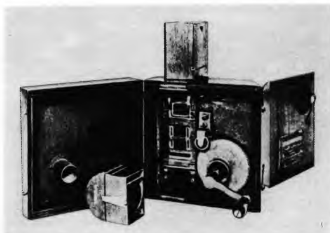
Sl. 8. Kinematografski uređaj braće Lumière: gore cijeli uređaj, dolje naprava za pokretanje filma (na stalku desno gore)
