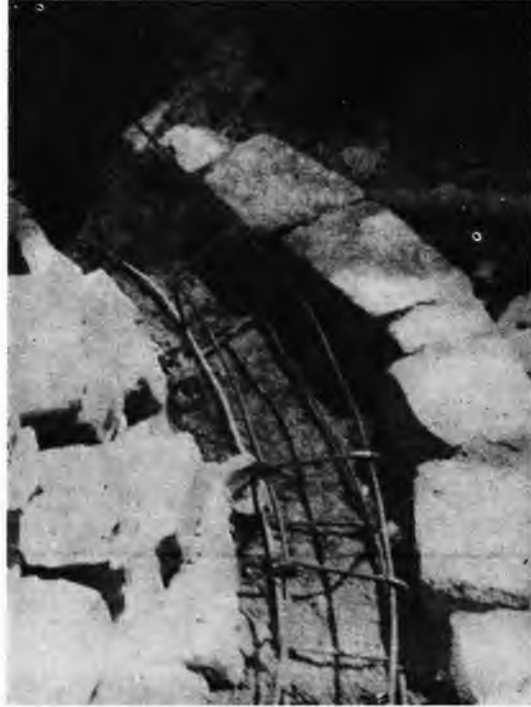
Sl. 10 Armiranobetonsko ojačanje temelja apside: dio serklaža u toku izvođenja (gore); tlocrt (lijevo) — brojke označuju redosljed betoniranja sektora; presjek serklaža (dolje)
