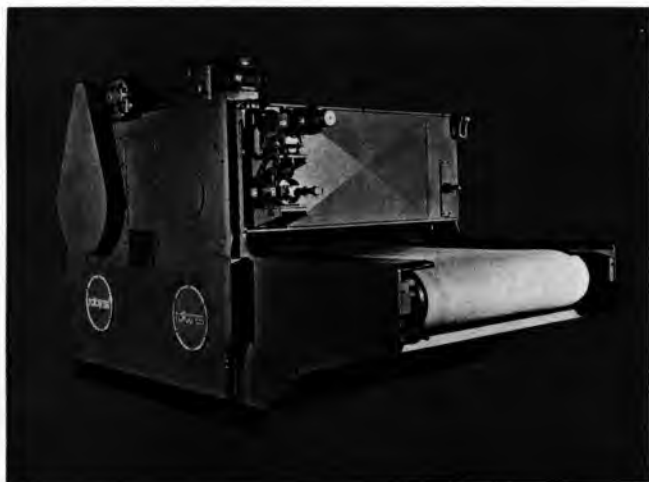
Sl. 24. Tipična protočna preša za glačanje kože
