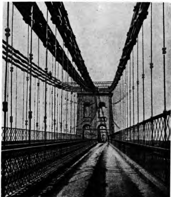
Sl. 11. Unutrašnjost mosta Menai Strait Bridge (sl. 10)
