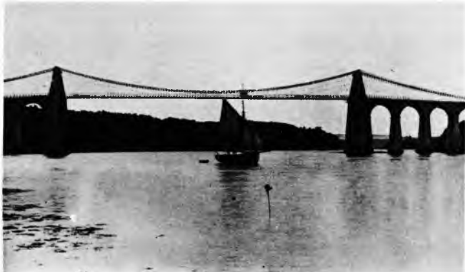
Sl. 10. Pogled na most Menai Strait Bridge, Bangor, Velika Britanija; gradnja od 1819. do 1826. Projektant Th. Telford
