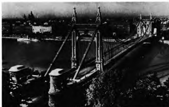
Sl. 16. Most Erzsébet hid na Dunavu u Budimpešti, prvobitni izgled. Most je u drugome svjetskom ratu srušen, a obnovljen je kao most sa žičanim kabelima. Varijantu s užetima projektirao Kübler, a varijantu s lancima izveo Czekelius
