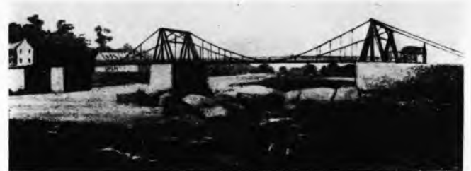
Sl. 5. Lančani most preko rijeke Shuylkill (Philadelphia, SAD) izgrađen 1809. godine. Projektant Templeman
