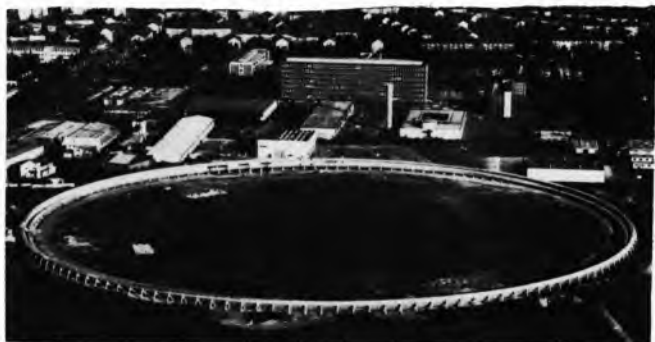
Sl. 30. Pokusni poligon za lebdeće pružno vozilo EET u Erlangenu, SR Njemačka. Promjer kruga 280 m, nagib pruge 45^\circ
