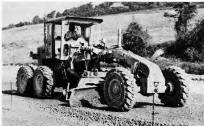
Sl. 8. Motor-grejder na planiranju donjeg sloja, sa uređajem za automatsko održavanje nivelete elektronom
