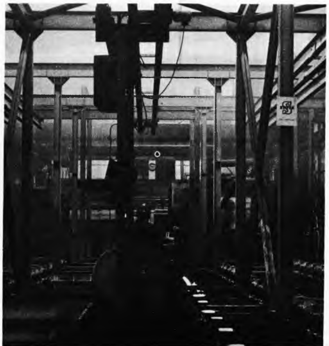
Sl. 81. Ručno ulijevanje loncem na ovjesnoj dizalici
