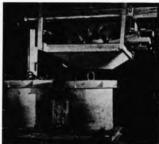
Sl. 73. Istovar zasipa iz težinskog spremnika u zasipne posude na transportnim kolicima
