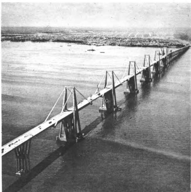
Sl. 198. Cestovni most preko zaljeva Maracaibo (Venezuela)
