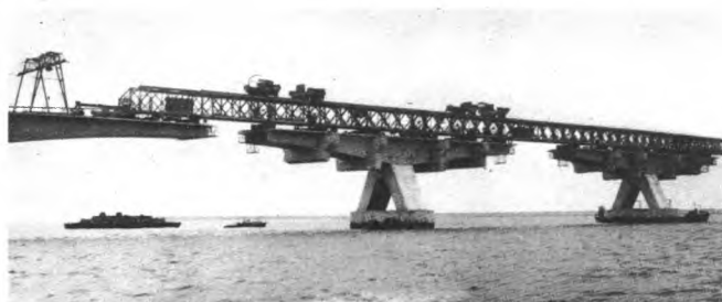
Sl. 209. Balansni postupak gradnje mosta Oosterschelde (sl. 207) s lansirnom rešetkom
