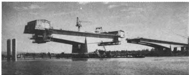
Sl. 205. Balansni postupak gradnje mosta kod Bendorfa
