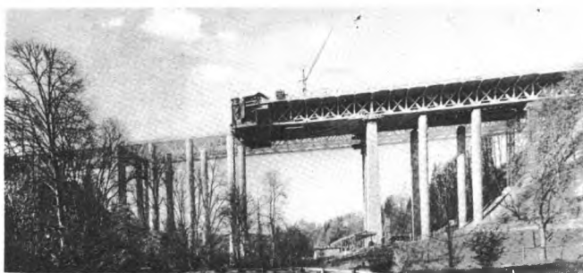
Sl. 156. Rešetkasti most od prednapregnutog betona
