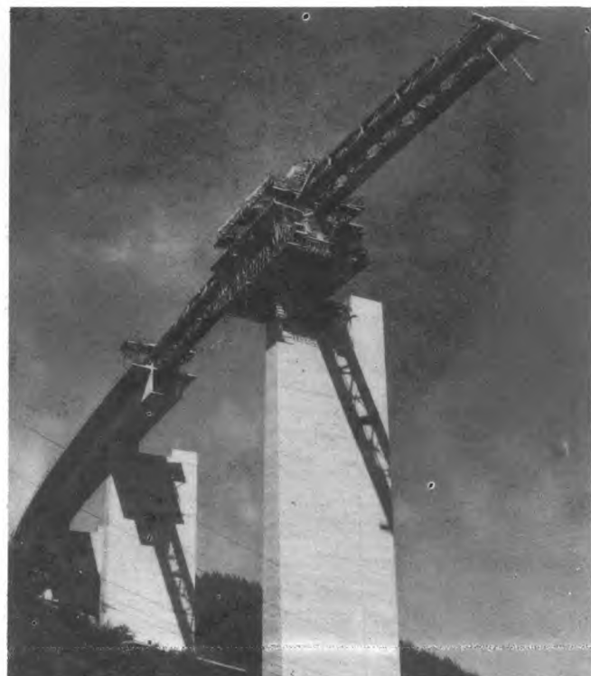
Sl. 221. Gradnja vijadukta preko doline Siegtal (sl. 220)
