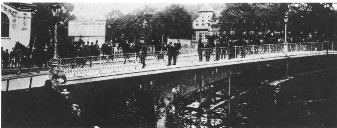
Sl. 187. Armiranobetonski most preko Ourthe u Liègeu (suvremena fotografija)
