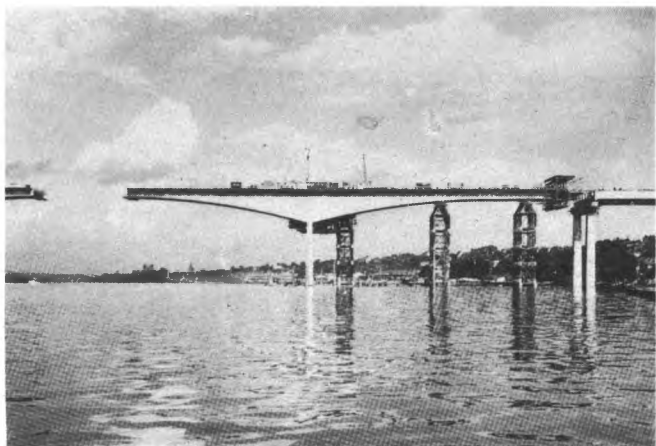
Sl. 203. Balansni postupak gradnje mosta preko rijeke Medway (sl. 202)
