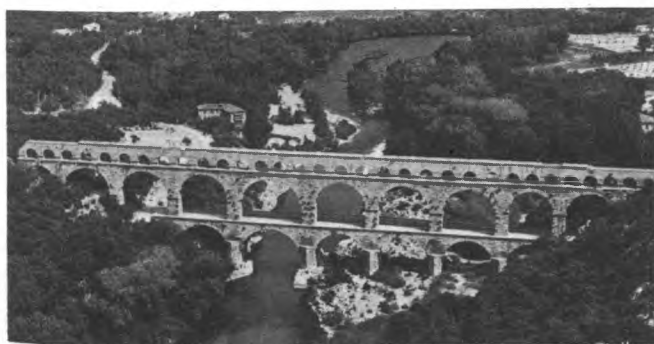
Sl. 161. Pont du Gard kod Nimesa u južnoj Francuskoj
