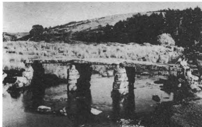
Sl. 159. Primitivni most s kamenim stupovima
