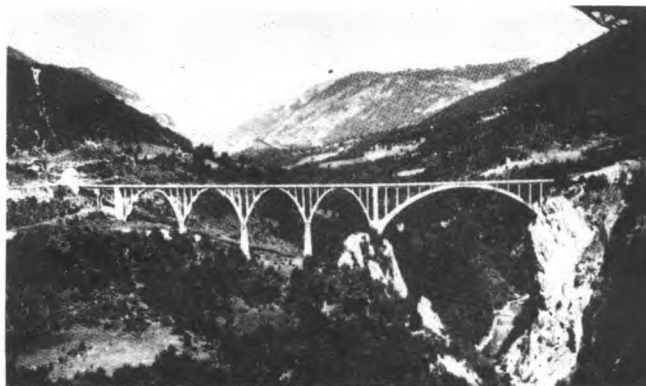
Sl. 176. Cestovni most preko Tare (projektant M. Trojanović)
