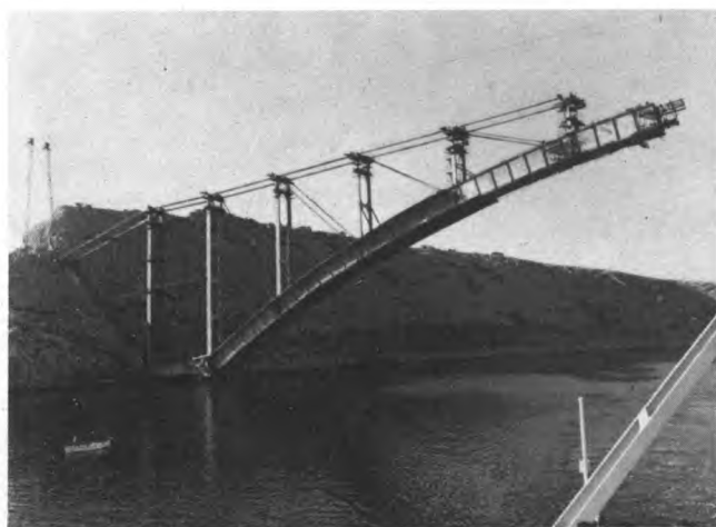
Sl. 186. Gradnja luka Titova mosta pomoću čeličnih zatega
