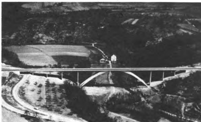
Sl. 182. Most preko doline potoka Glems kod Schwieberdingena (SR Njemačka)
