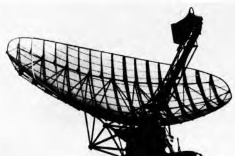
Sl. 56. Antena brodskog osmatračkog radara za rano otkrivanje zračnih ciljeva
