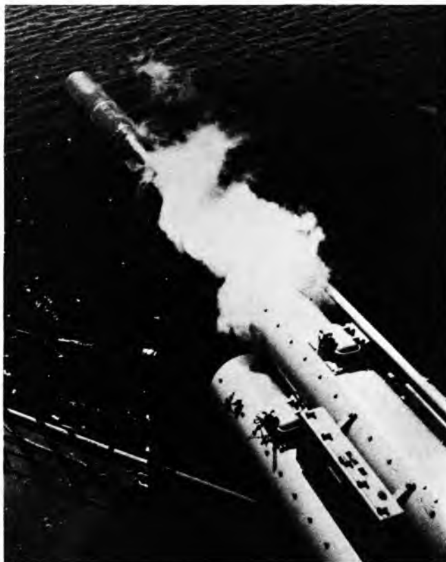
Sl. 33. Lansiranje lakog protupodmorničkog torpeda iz trocijevnog torpednog aparata na palubi broda
