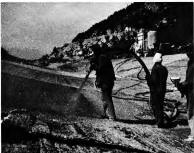
Sl. 40. Primjena mlaznog betona za sanaciju vodopropusnosti riječnog korita
