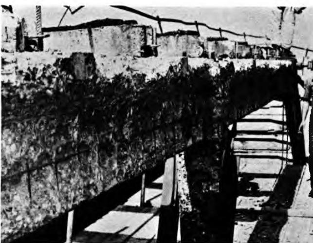
Sl. 36. Oštećenje betonske konstrukcije od požara
