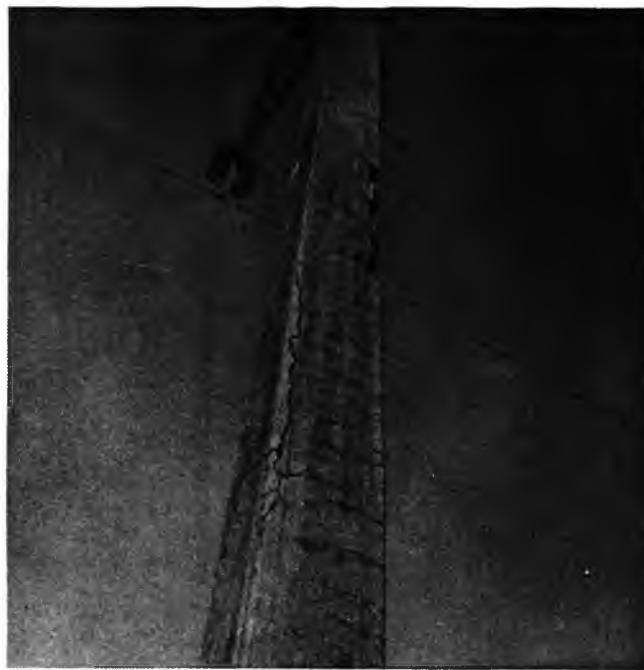
Sl. 38. Pukotine u betonu nastale korozijom betonskog čelika (bubrengi)
