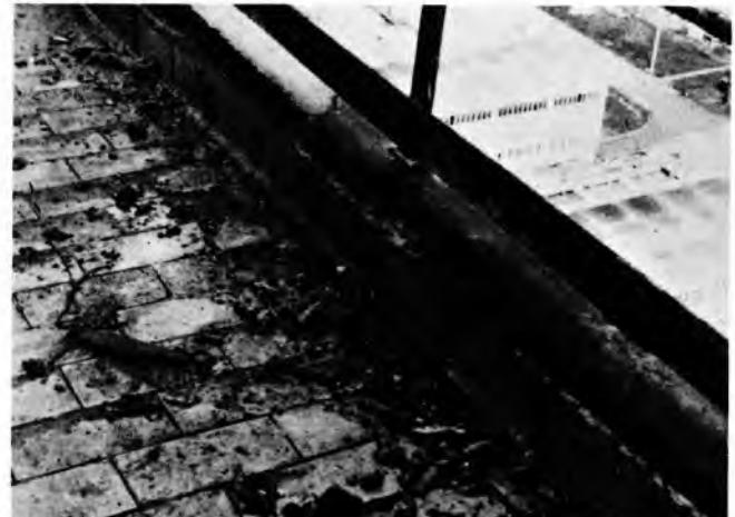
Sl. 39. Oštećenje betona zbog djelovanja agresivnih soli i smrzavanja (u kemijskoj industriji)
