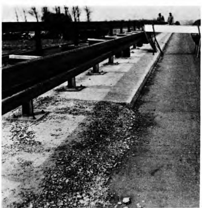
Sl. 37. Oštećenje betona zbog djelovanja niskih temperatura i soli za odleđivanje
