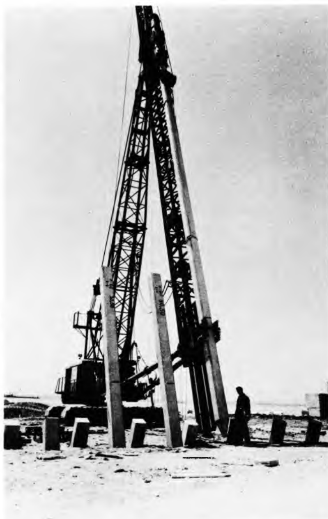
Sl. 9. Zabijanje kosih pilota od armiranog betona u luci u Limassolu
