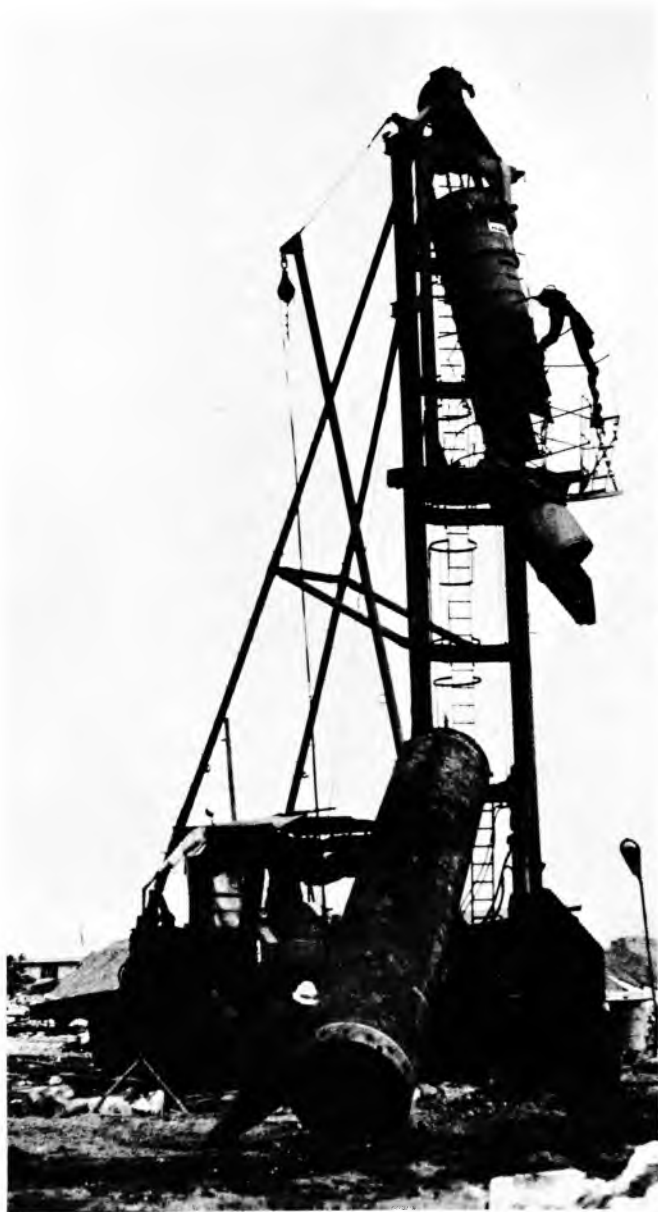
Sl. 24. Uređaj za izvedbu Benoto-pilota (Pomgrad, Split)
