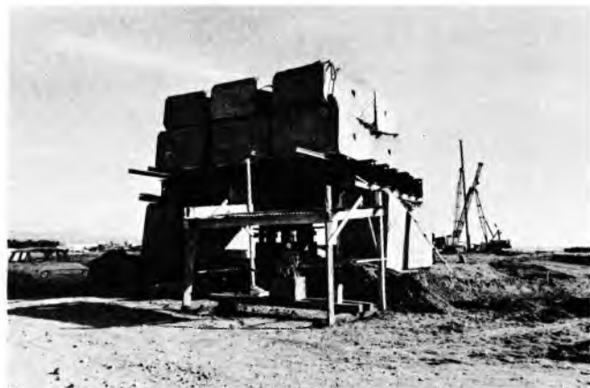
Sl. 34. Pokusno opterećenje pilota na gradilištu luke u Limassolu
