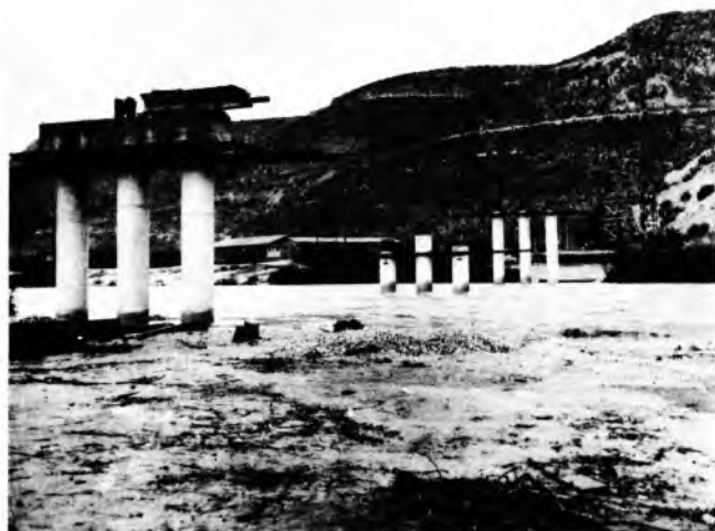
Sl. 26. Armiranobetonski Benoto-piloti promjera 1200 mm za most preko Neretve u Žitomislićima. Na prednjim pilotima izgrađena armiranobetonska greda
