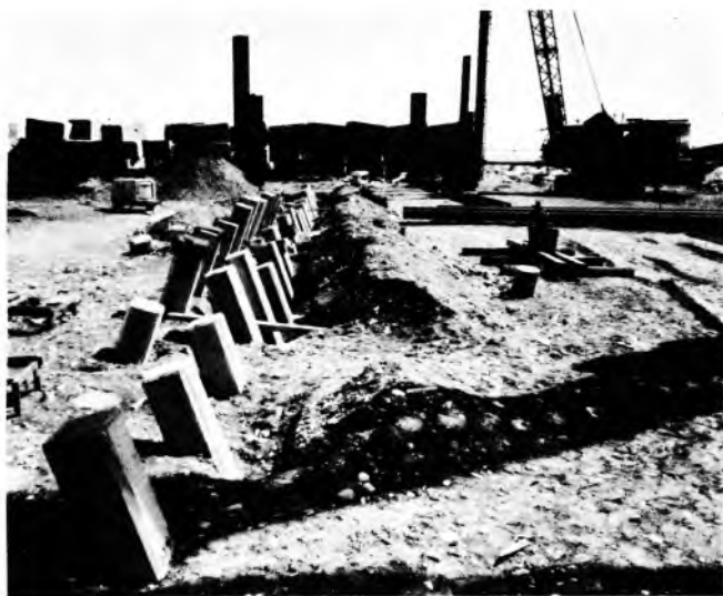
Sl. 10. Zabijeni kosi piloti od armiranog betona u luci u Limassolu
