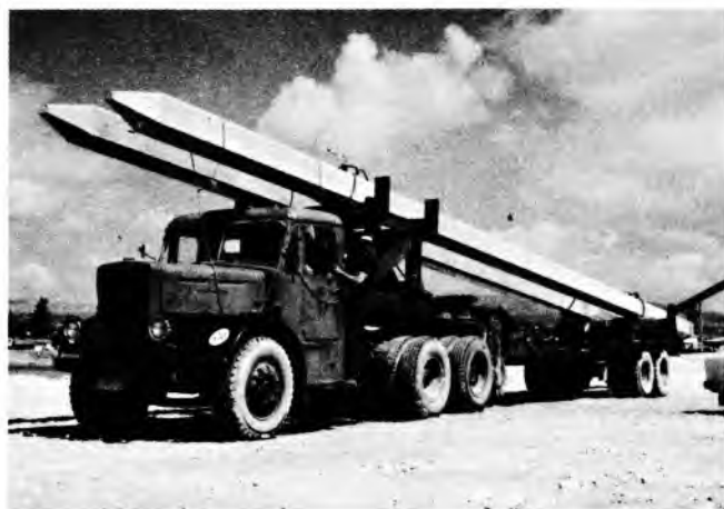
Sl. 8. Transport pilota od armiranog betona za luku u Limassolu
