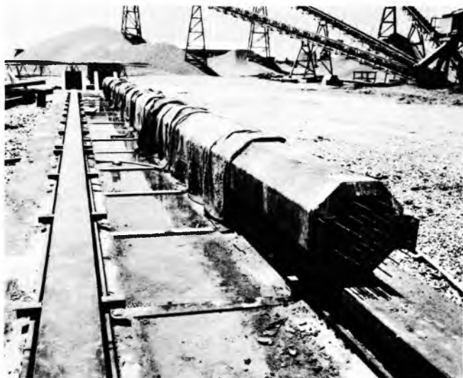
Sl. 7. Izvedba pilota od prednapregnutog betona za luku u Limassolu; izvođač Pomgrad, Split
