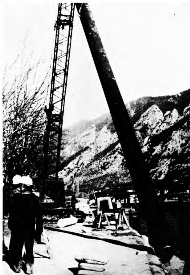
Sl. 13. Podizanje čelične cijevi promjera 508 mm za izradbu zabijenog čeličnog pilota za gradnju putničke obale u Kotoru; izvođač Geotehnika, Zagreb
