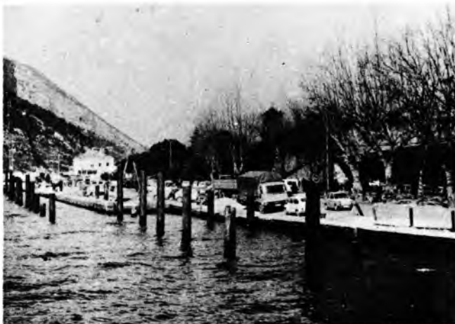
Sl. 16. Zabijeni čelični piloti s ugrađenom armaturom i ispunjeni betonom na gradilištu putničke luke u Kotoru
