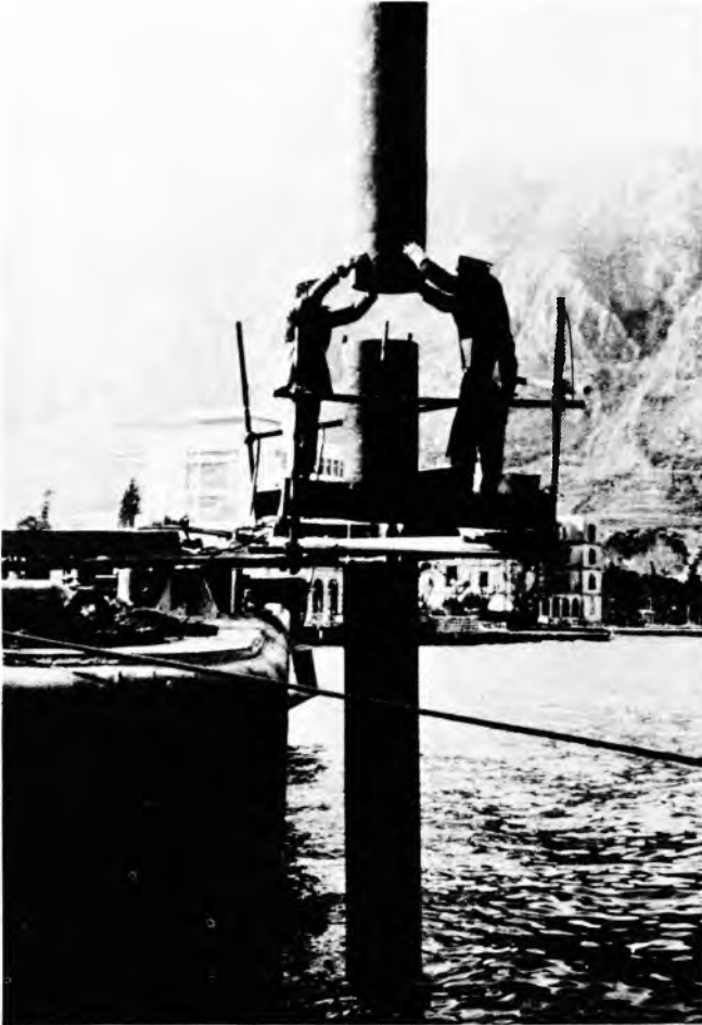
Sl. 15. Nastavljanje čelične cijevi promjera 508 mm na već zabijenu cijev na gradilištu putničke luke u Kotoru
