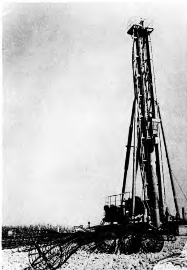
Sl. 19. Stroj MT-VI za izvedbu Franki-pilota promjera 520 mm da se u određenoj fazi rada ubacuje unaprijed pripremljen armaturni koš (sl. 19).
