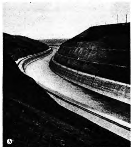
Sl. 12. Albertov kanal Lüttich—Antwerpen. a u gradnji, b završen
