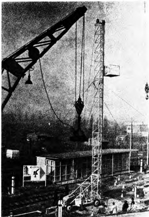
Sl. 124. Cestovni brzi građevinski lift nosivosti 630 kg postavljen za visinu dizanja 22,5 m
