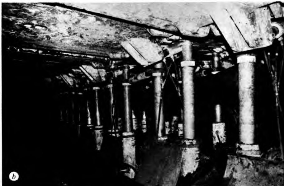
Sl. 10. Velenjska otkopna metoda sa samohodnom hidrauličnom podgradom. a shema, b radni snimak
