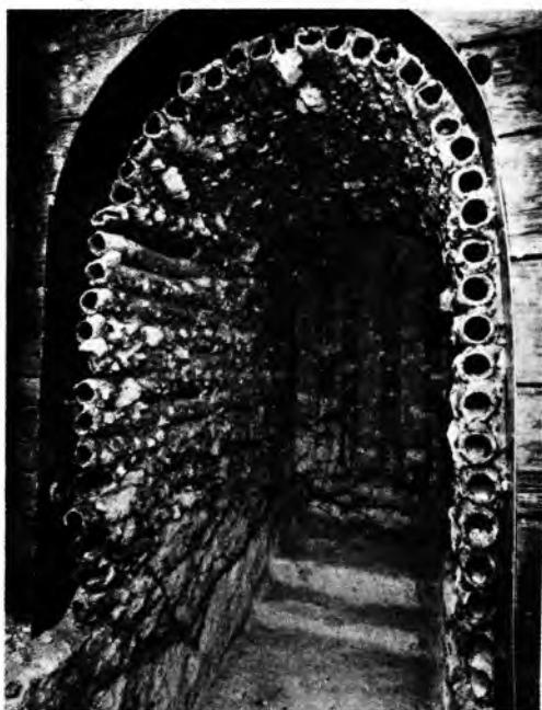
Sl. 11. Hodnik poduprt zastakljenim bušotinskim kanalima izrađenim termičkom bušilicom
